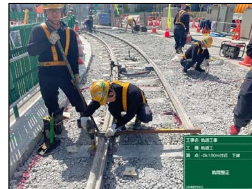
カントの見直し工事の様子
