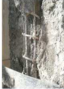
写真3 支柱の下部の状況
